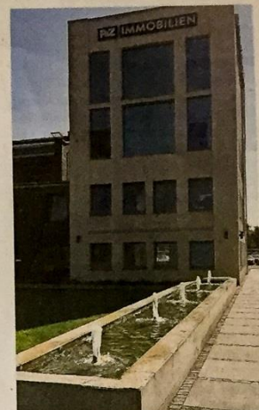
Vor dem alten Kesselhaus sprudelt jetzt ein Wasserspiel.
